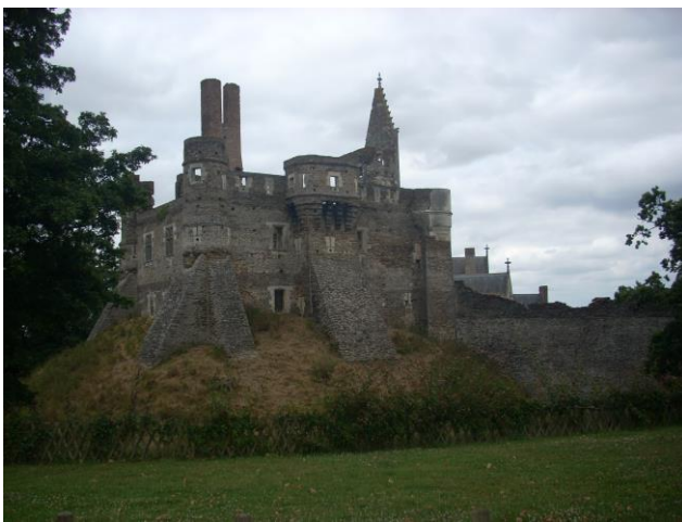
写真⑤：プレシ=マセ城砦（15世紀末、ルイ11王が西方のブルターニュ公領監視のために作らせた城砦。アンジェ市から車で約1時間半、公共交通機関では行くのが難しい。）
