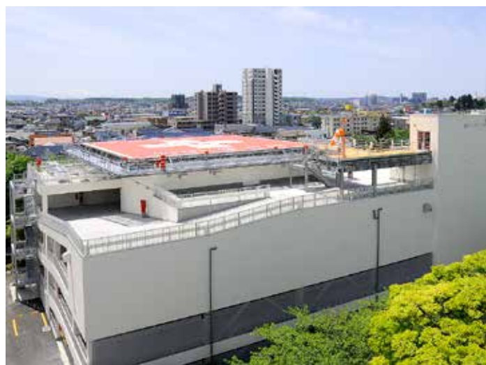
ヘリポート及び立体駐車場
