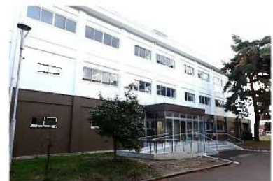
(手形)理工学部2号館(M棟・G棟)改修
