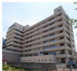
(医病)第一病棟改修
