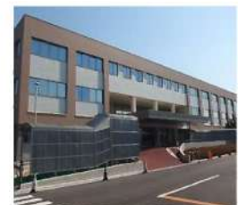
(医病)外来棟・中央診療棟改修
