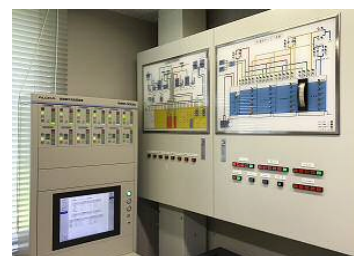
放射線監視システム
