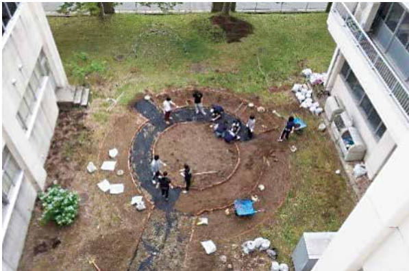
写真1 砂利を一度撤去し防草シートを敷く作業を行いました。
