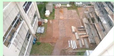
改修工事のため鉄板が敷かれて使えなくなった庭
