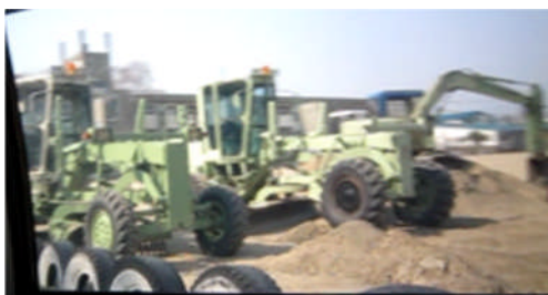
校庭に置かれた重機
