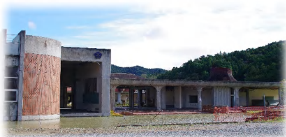
被災した当時の状況を物語る大川小学校跡地
