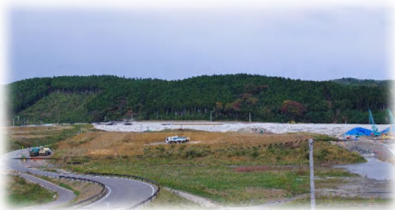
南三陸盛土工事の様子
