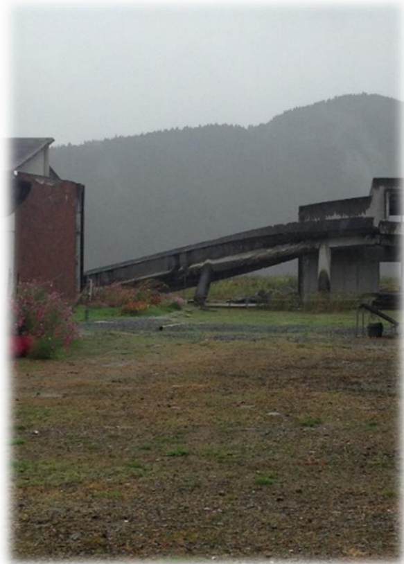
校舎と体育館をつなぐ渡り廊下跡
