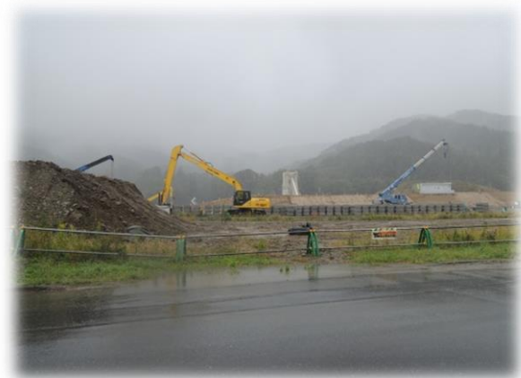
雄勝地区の復興工事の様子
