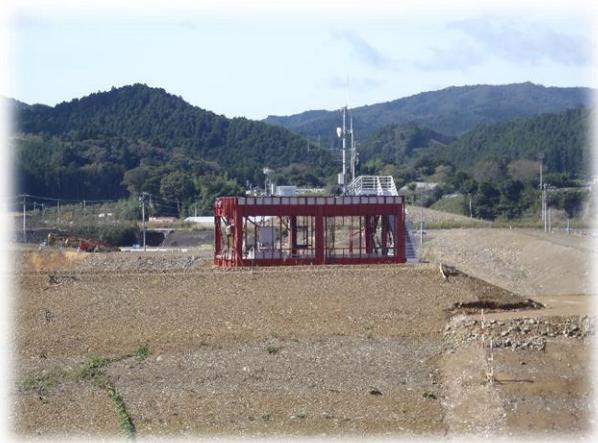
南三陸町防災庁舎跡（下の部分は見えない。周りはかさ上げされた地面）
