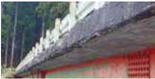
凍害により劣化した鋼筋コンクリート床版橋
