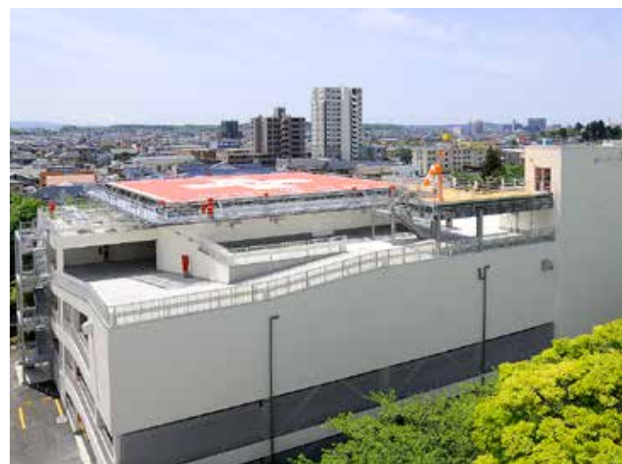
ヘリポート及び立体駐車場
