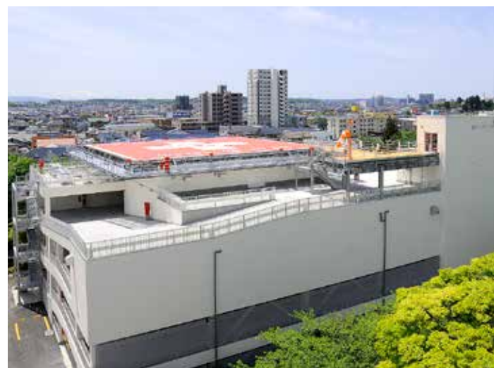
ヘリポート及び立体駐車場
