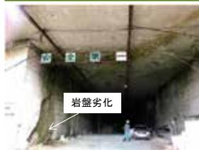
図a1 県内の凝灰岩採石場の岩盤の劣化状態
