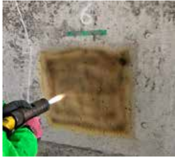
コンクリート表面に樹脂を溶射
