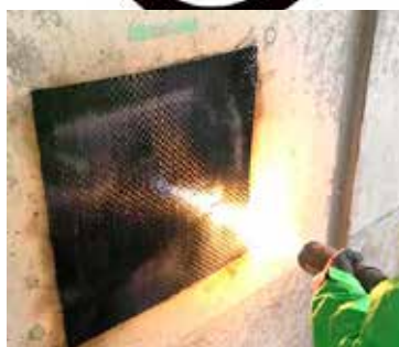
炭素繊維シートを仮止めて上から改めて加熱してコンクリートと炭素繊維シートとの間の樹脂を溶融接着
