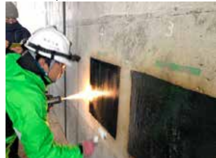
炭素繊維シートを仮止めて上から改めて加熱してコンクリートと炭素繊維シートとの間の樹脂を溶融接着
