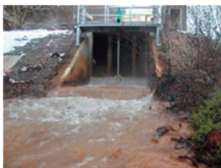
Active Treatment 人工的な中和処理
