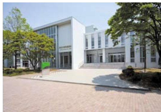
附属図書館本館
