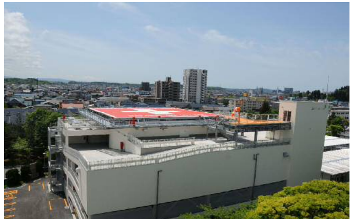
ヘリポート及び立体駐車場
