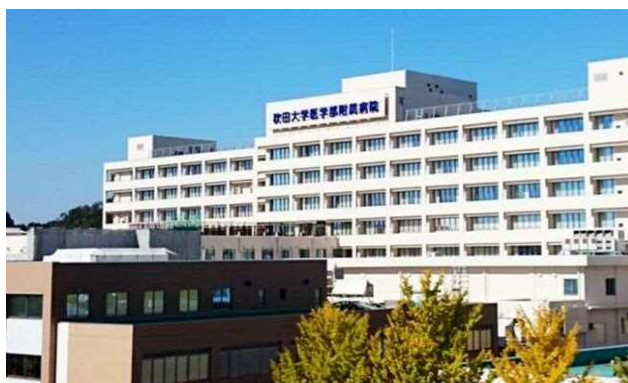
再開発整備事業が完了した附属病院
