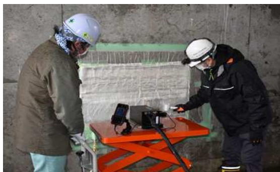
令和3年3月 試験施工の様子
